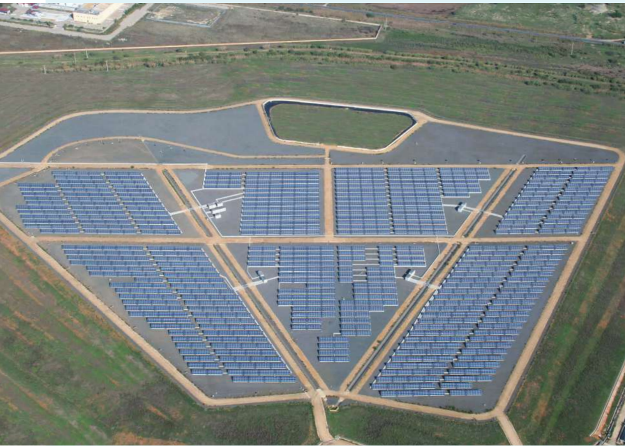
Enipower S.p.A. - Impianto fotovoltaico da 5MW (Gela)
